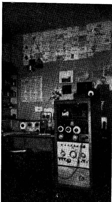
Vue de l'ensemble de la station
